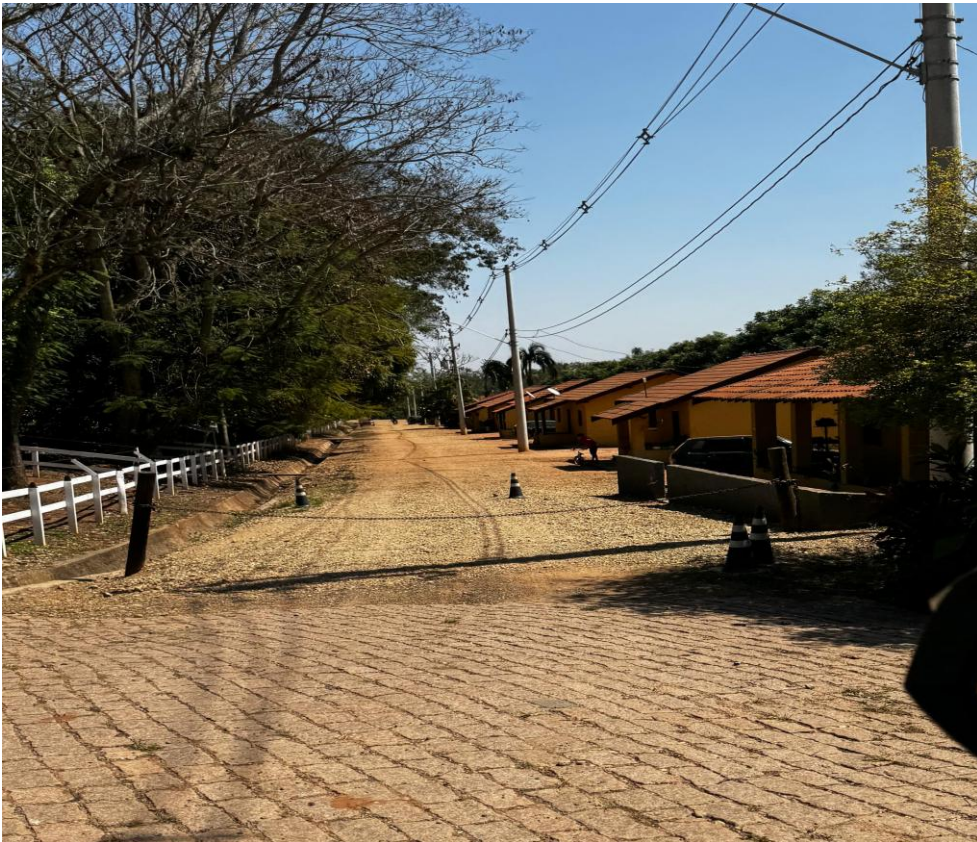
ENTRADA FAZENDA/ RESIDENCIAS FUNCIONÁRIOS
