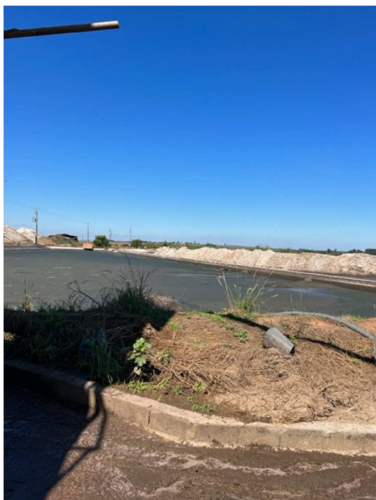
Figura 22- Logo a céu aberto- local de recebimento de dejetos – lavagem do chão do estábulo
