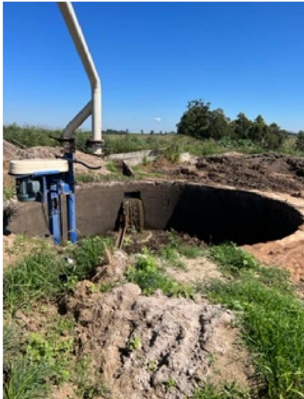
Figura 21- Local de recebimento de dejetos – lavagem do chão do estábulo Fonte: autores em visita técnica
