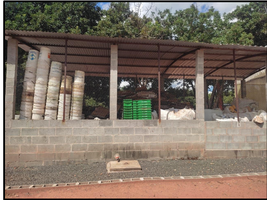
Figura 8: Galpão destinado ao descarte de embalagens de produtos químicos
