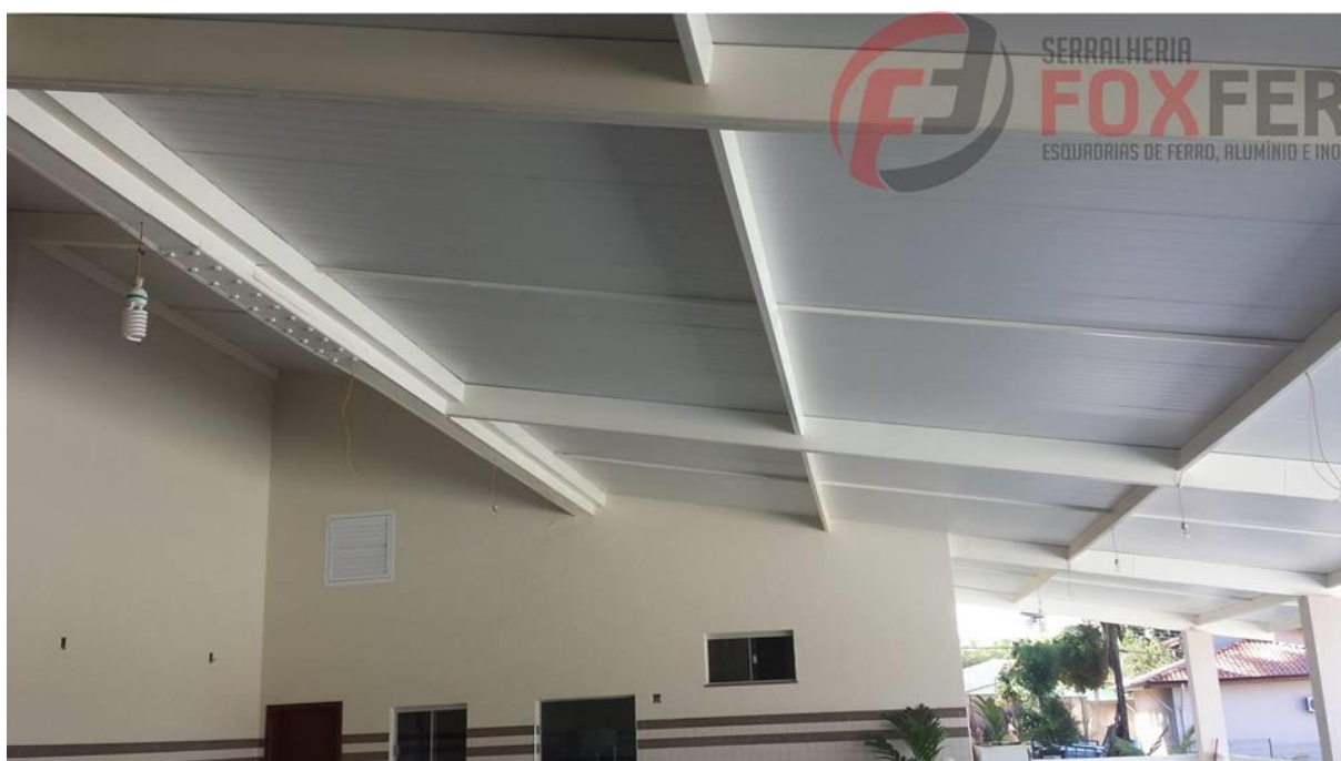
Estrutura, Cobertura Telhas Termo Acústica com Pintura Eletrostática.
