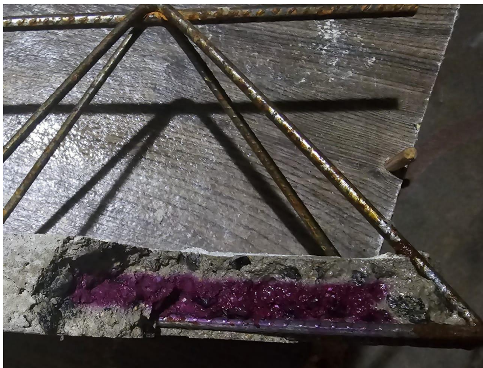
Foto 5 – Amostra de concreto após a aplicação da fenolftaleína
