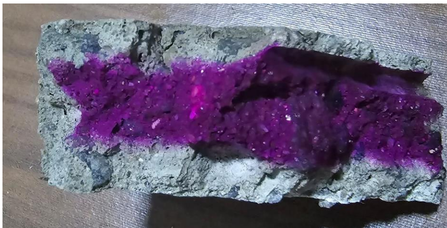
Foto 1 – Amostra de concreto após a aplicação da fenolftaleína
